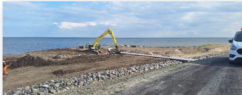
Werkzaamheden aan de Markermeerdijken
